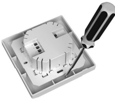
Рисунок 5. Демонтаж лицевой панели
